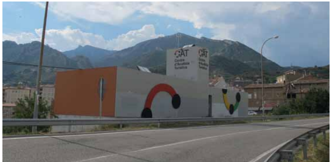
Construït el 2011, l'edifici del Centre d'Atenció Turística (CAT) de Berga continua tancat. (ARXIU MP)
