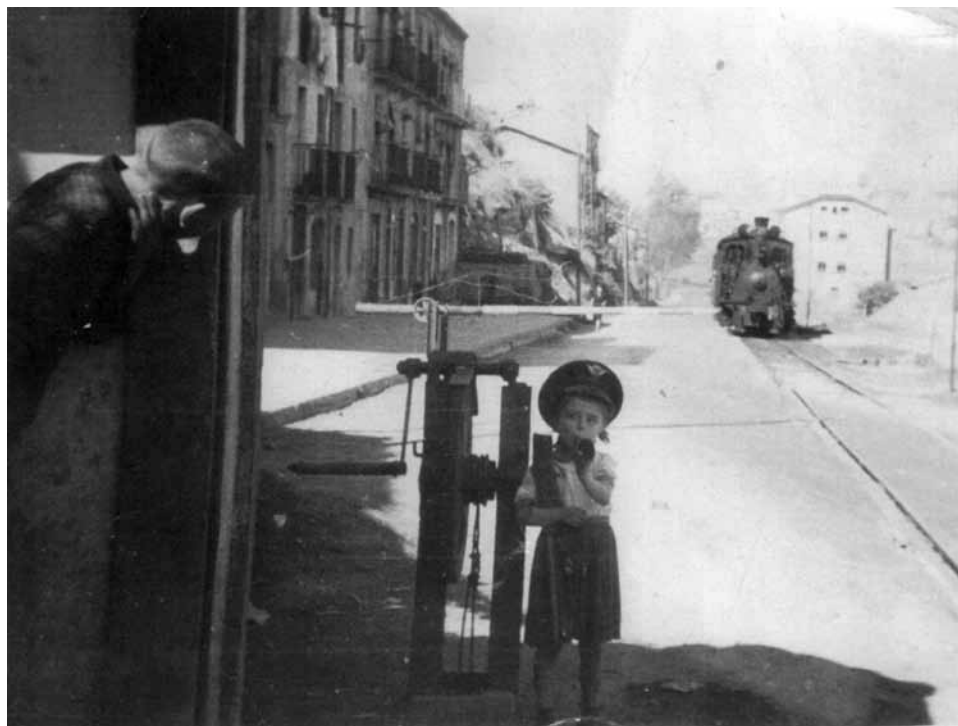
Pas a nivell del tren a Cal Bassacs (ARXIU PILAR LATRILLA/PARC FLUVIAL DEL LLOBREGAT)
