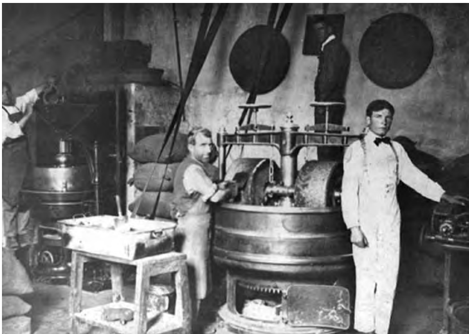
Part de la secció de fabricació cap a 1915. A l'esquerra, Jaume Fàbregas, al costat del molí de cacau; a la dreta, Ignasi Fàbregas, recolzat a l'afinadora; enmig, dos treballadors. S'observen dues corretges de l'embarrat. (FOTO DE L'ARXIU D'EDUARD PUJALS)
