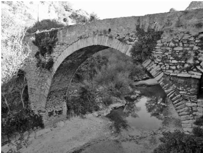
Pont del Collet d'Eina (Arxiu ARB)
