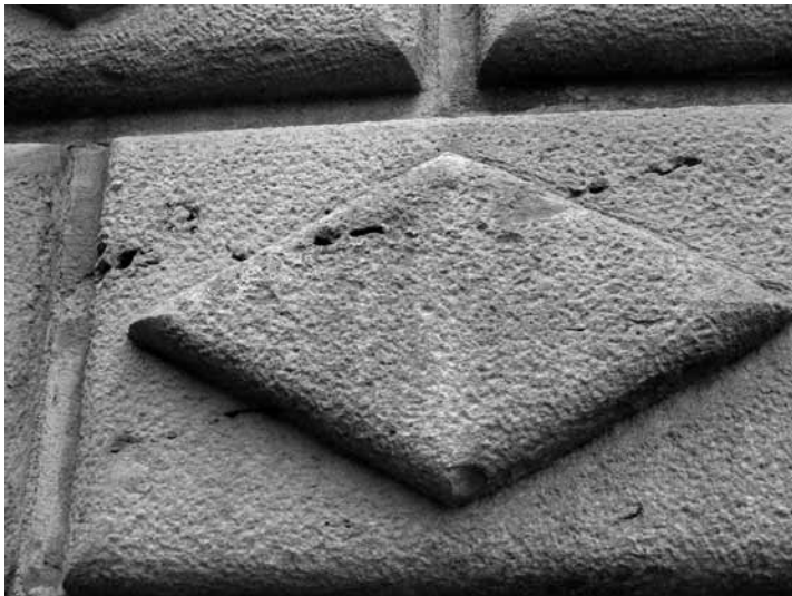
Les restes de l'impacta de les bales a la façana de l'església barcelonina de Betlem que el 6 d'octubre de 1936 van disparar contra Àngel Serra. (ARXIU FAMÍLIA SERRA VILANOVA)
