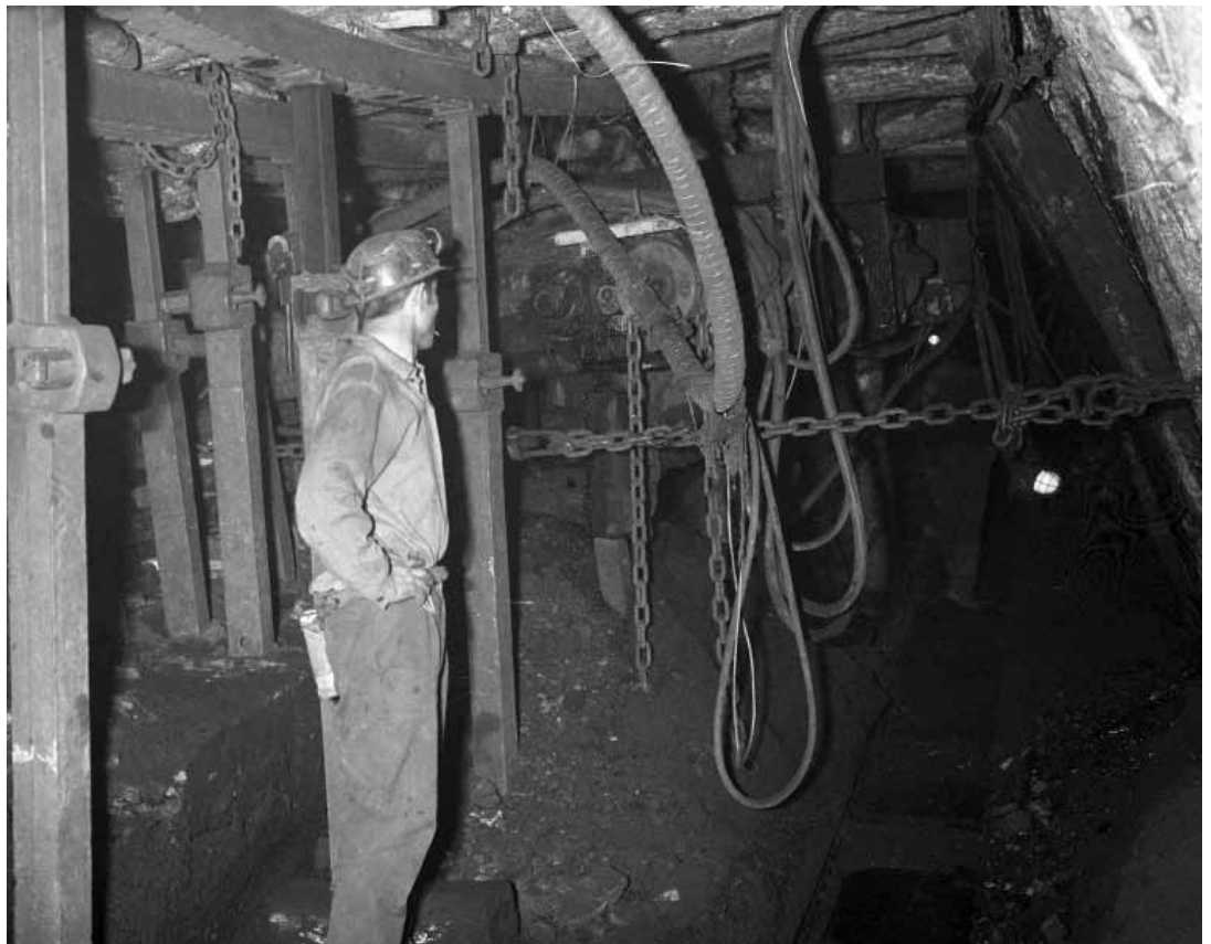
Detall del "Luneto", l'espai destinat a encabir-hi els motors i reductors del raspall i del panzer en el front de l'exploració. (ARXIU COMARCAL DEL BERGUEDÀ, FONS JOSEP DESEURAS, 04013050004245, 007)
