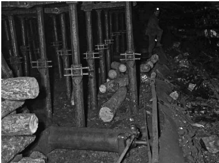
La fotografia mostra el sistema de apuntalament del sostre de l'exploració mitjançant els puntals o "estemples" metàl·lics de fricció i les gàbies de fusta. S'aprecia amb tota claredat el panzer o transportador blindat, i el cilindre pneumàtic, anomenat "porc" segons l'argot de la mina, que empenyia el panzer cap al front d'exploració. (ARXIU COMARCAL DEL BERGUEDÀ, FONS JOSEP DESEURAS, 04013050004244, 008)
