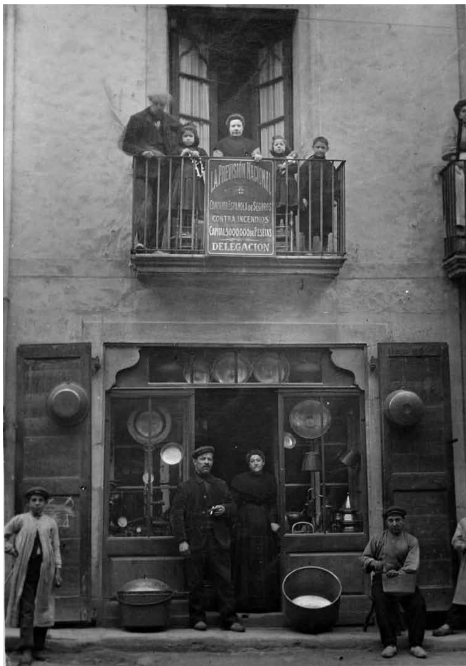
Desapareguda caldereria Malga de Ripoll l'any 1912.
