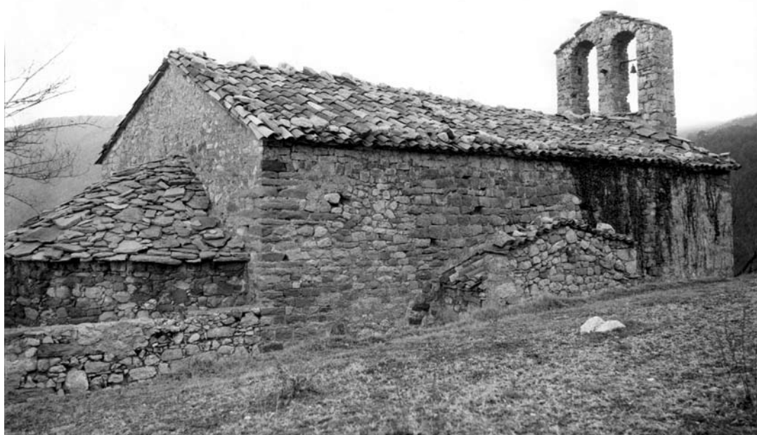
L'església de Sant Jordi de Cercs, en una fotografia retrospectiva, abans de ser restaurada per l'SPAL el 1986.
