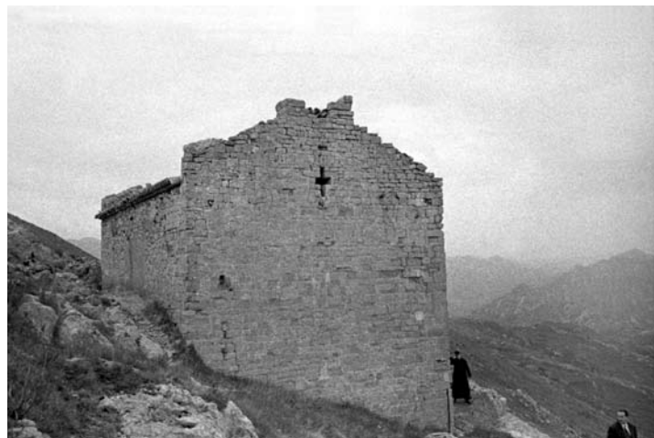
Segons que explicava mossèn Escobet, el temple "se resiente del paso de los siglos y en la actualidad, su techo está deteriorado". FOTO: ARXIU SPAL, MAIG DE 1956.
