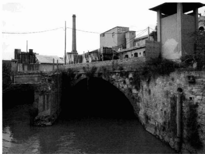
Desguàs, fàbrica i xemeneia de la fàbrica Cots (FOTO LL. VIRÓS)
