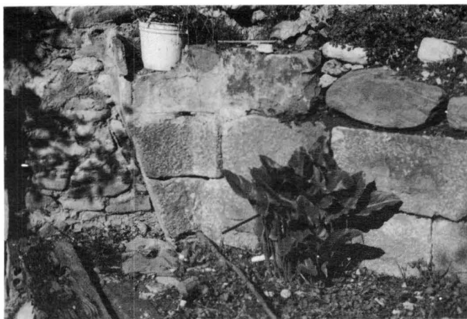
Detall del sòcol primitiu de l'estrep de l'esquerra del pont de Terradelles. Es poden apreciar les primeres dovelles de l'arcada (des d'aigües avall).
