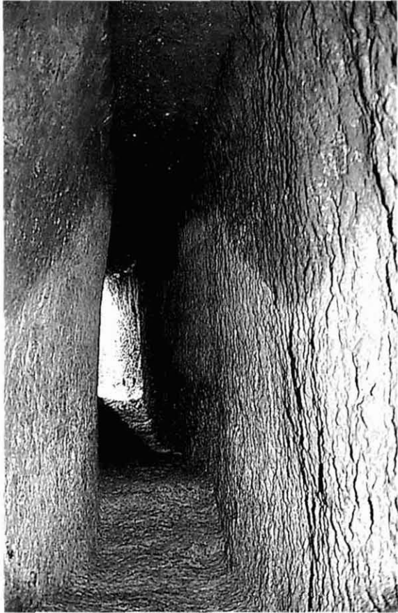
Figura 2. Vista de l'interior del cuniculus. Foto MNAT – Albert Saludes.
