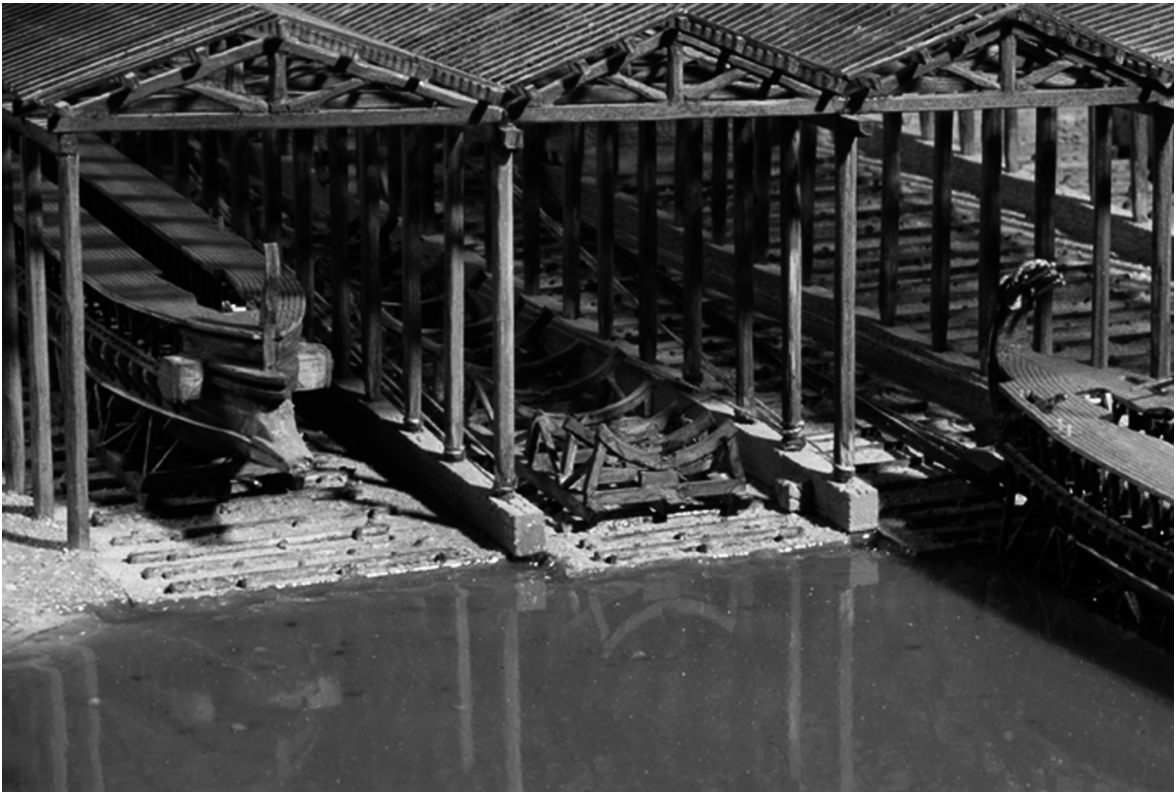
Figures 4-5. Place Jules-Verne, cales de halage et Place Villeneuve-Bargemon, hangars à bateaux (Musée des Docks Romains, maquette Delpalillo, photos CCJ).
