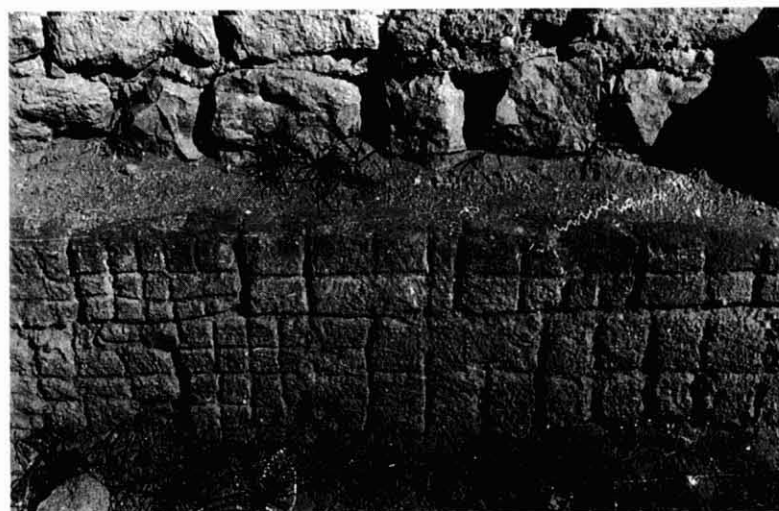
Figures 10, 11, 12. – Detall de la tècnica de construcció del mur fortificat de la Neàpolis d'Empúries. Detall de l'aparell de a muralla romana d'Empúries. Cisterna d'Empúries amb els carreus estriats per facilitar l'adherència de l'estuc.
