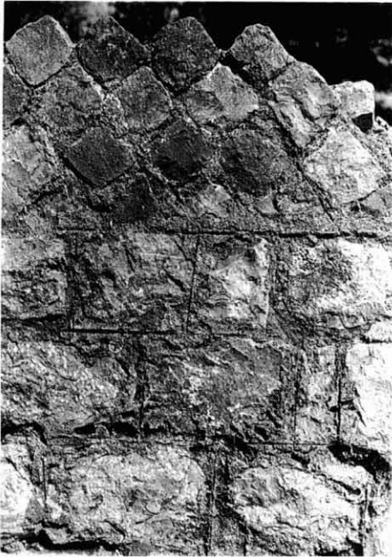
Figura 6. – Opus reticulatum i fals aparell amb junts fets al ferro en una casa romana de la Neàpolis (segle I aC).
