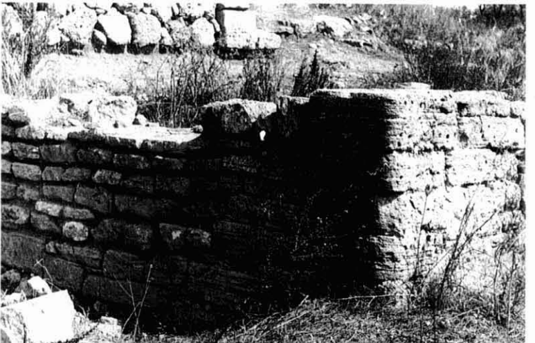
Figures 7, 8, 9. – Opus mixtum o mur format per materials diferents. Enfilades de pedres alternades amb altres de tégulae . Cantonada d'una vil·la situada vora el Fòrum d'Empúries. Murs fets amb opus quadratum i la cantonada reforçada amb grossos carreus. Cantonada d'una casa romana de Pollentia que ofereix les mateixes característiques que la d'Empúries.
