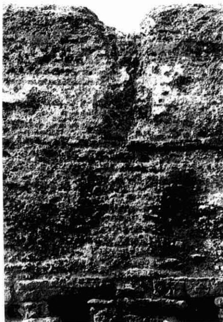
Figura 13. - Detall de l' opus caementicium de la muralla de la ciutat romana d'Empúries amb les capes de les morteres.
