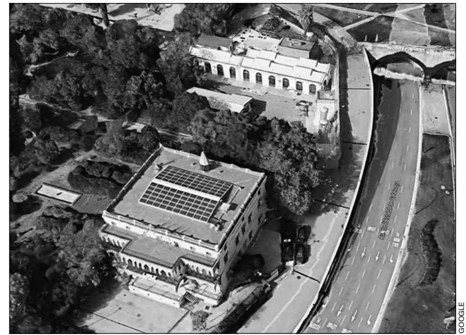
Instal·lacions de la SGAB al Parc de les Aigües
