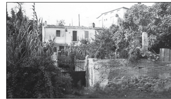
Cases afectades del carrer Llobregós, 30-32
