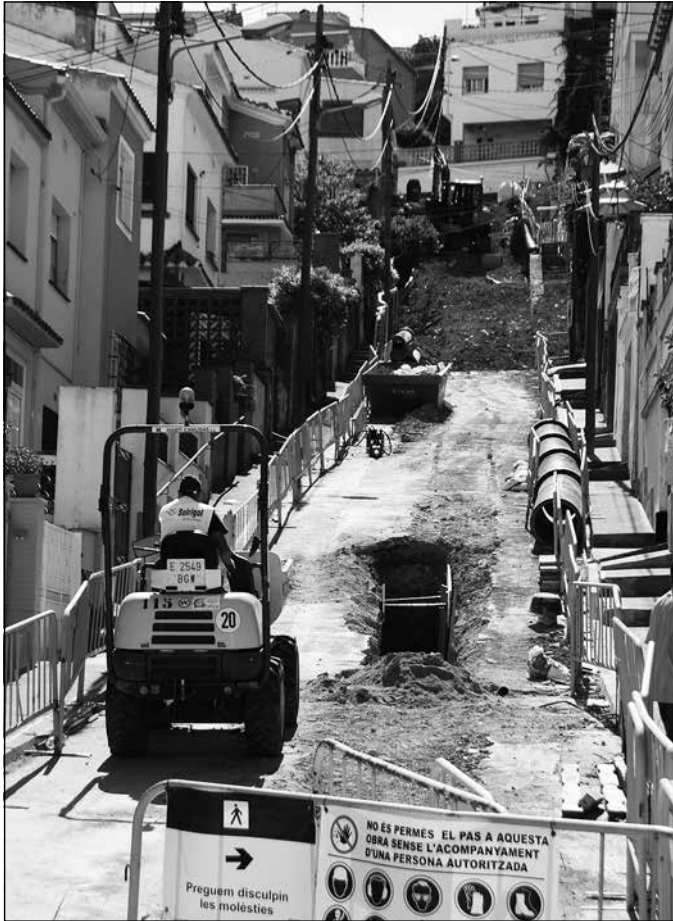
Obres de rehabilitació del passatge de l'Arc de Sant Martí
