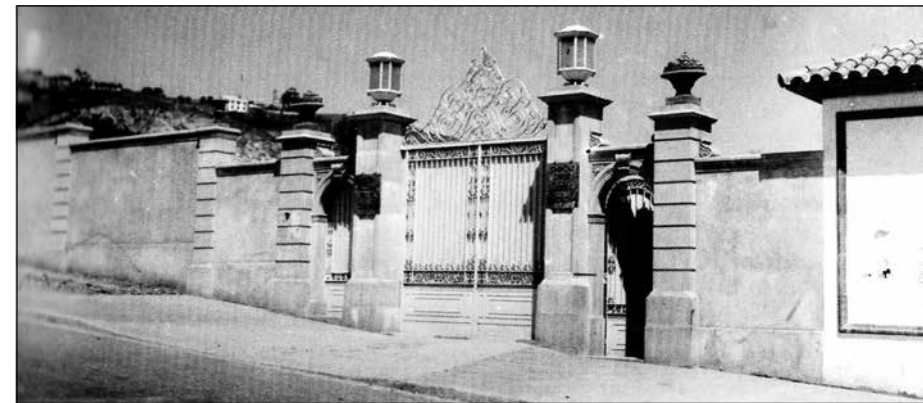
Entrada a la Colònia Ferrer i Guàrdia al recinte de Les Altures pel carrer Sardènyia a l'any 1937. En una placa hi ha escrit Sindicat d'Obrers Aigües de Barcelona
