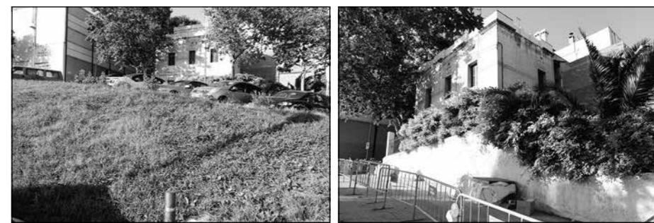
Refugi núm. 64, casa del carrer Josep Ciurana que fa cantonada amb el de Thous. Passava per sota del carrer i sortia dintre del recinte de la Cia. de les Aigües en el desnivell que veiem a la foto
