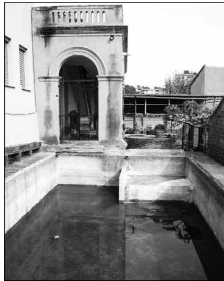
Bassa a l'hort de la Granja que recollia l'aigua de la xarxa de mines de la finca
