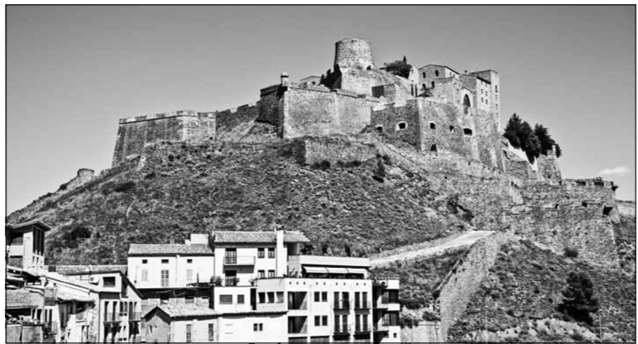
Vista general del castell de Cardona
