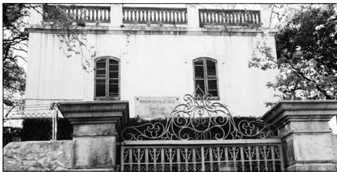
Instal·lacions de l'aqüeducte de Dosrius al parc de les Aigües
