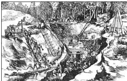
Gravat de la construcció de Dosrius
