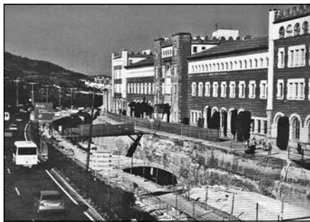
Construcció del metro el 1989
