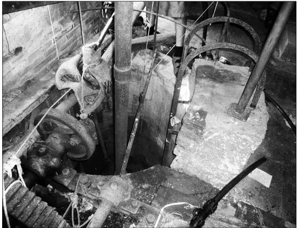
Maquinària al pou de 60 metres de fondària
