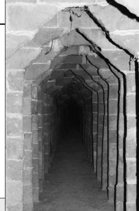
Vista panoràmica de l'edifici al costat del passeig de la Vall d'Hebron i Collserola al fons, als anys quaranta. A sobre, passadís entre els envans de les golfes que suporten la teulada
