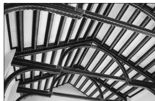
L'església amb la Teixonera al fons. A sota, sostre de l'església amb les bigues originals. A la dreta, balustrada de l'escala
