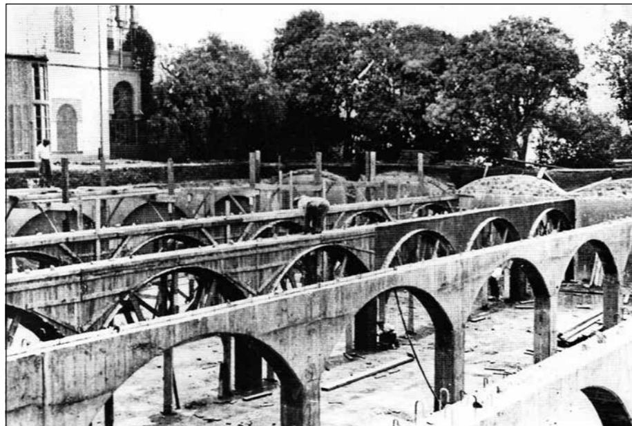
Construcció del dipòsit de les altures al Parc de les Aigües l'any 1870
