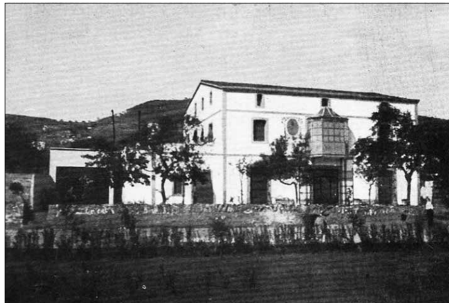
L'Institut Ravetllat-Pla a les seves instal·lacions de la masia de can Hortal
