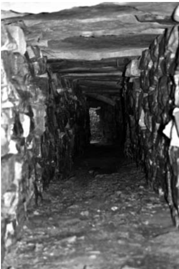
Tram superior de la mina. Sota l'enllosat del pis transcorre la canonada ceràmica. A la dreta, els dos brolladors de la sortida de les dues probables mines. El brollador de dalt, fosc, rajant, i l'altre brocal, el més proper, sec des de fa anys.
