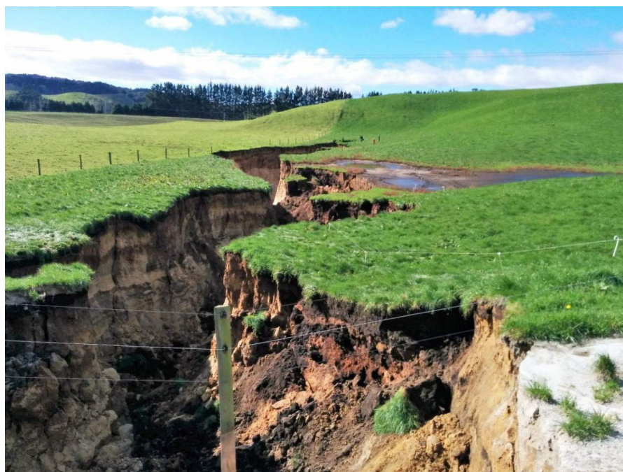
Fig. 1. Arriba, la grieta aparecida en el Valle del Rift, Kenia en marzo de 2018. (Foto tomada de la edición digital de The Guardian https://www.theguardian.com/science/blog/2018/apr/06/africa-is-slowly-splitting-in-two-but-this-crack-in-kenya-rift-valley-has-little-to-do-with-it#img-1 ).
