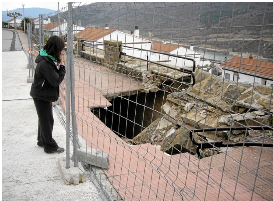
Fig. 3. Daños producidos en la urbanización desalojada, situada en el deslizamiento de la margen derecha de la presa de Yesa.
