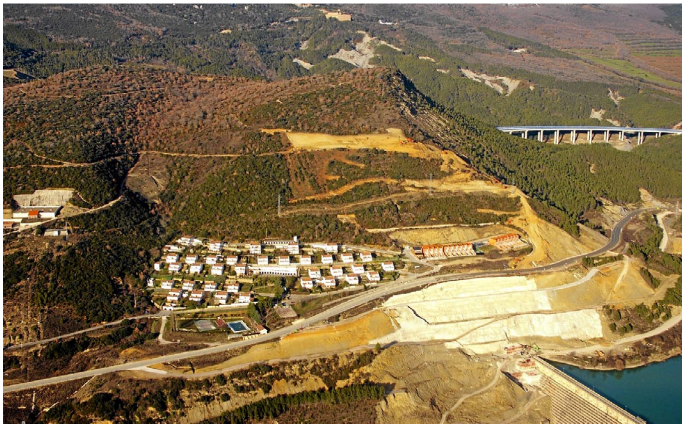
Fig. 2. Fotografía de la margen derecha de la presa de Yesa donde aparece la urbanización desalojada debido al deslizamiento y los daños en las viviendas.
