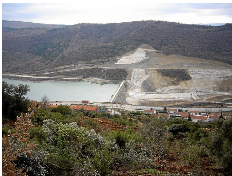
Fig. 1. Fotografía que muestra la ladera izquierda de la presa de Yesa, con la morfología característica de los deslizamientos de ladera. Obsérvese, a la derecha de la presa en la fotografía (sector oeste) los cambios de orientación de las capas del flysch de Yesa.
