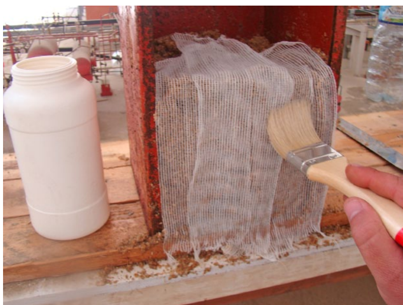
Fig. 6. Aplicación de la última capa sobre la gasa de algodón
