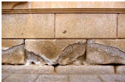
Fig. 9. Desplacado y subeflorescencias en sillares de granito.
