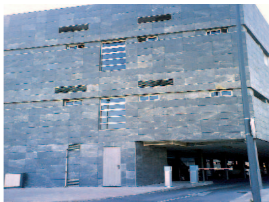
Fig. 5. Edificio con revestimientos externos de pizarra.
