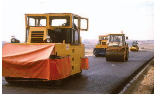
Fig. 12. Preparación de la capa de rodadura de una carretera con el material bituminoso, junto con el árido, como componentes principales.
