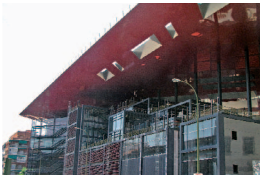
Fig. 10. Edificio con elementos estructurales de metal.
