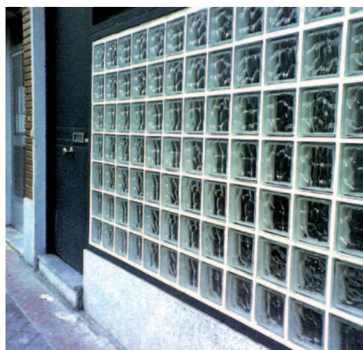
Fig. 9. Piezas de vidrio (pavés) en fachadas.
