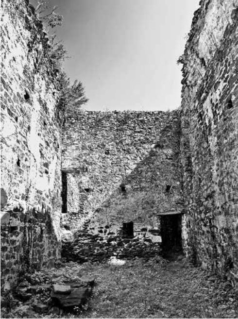
Fig. 2. En el moment d'iniciar la intervenció existia un mur que separava la nau de l'absis, construït amb posterioritat a l'abandó de l'església. De fet, convertia aquest sector en un petit habitatge.
