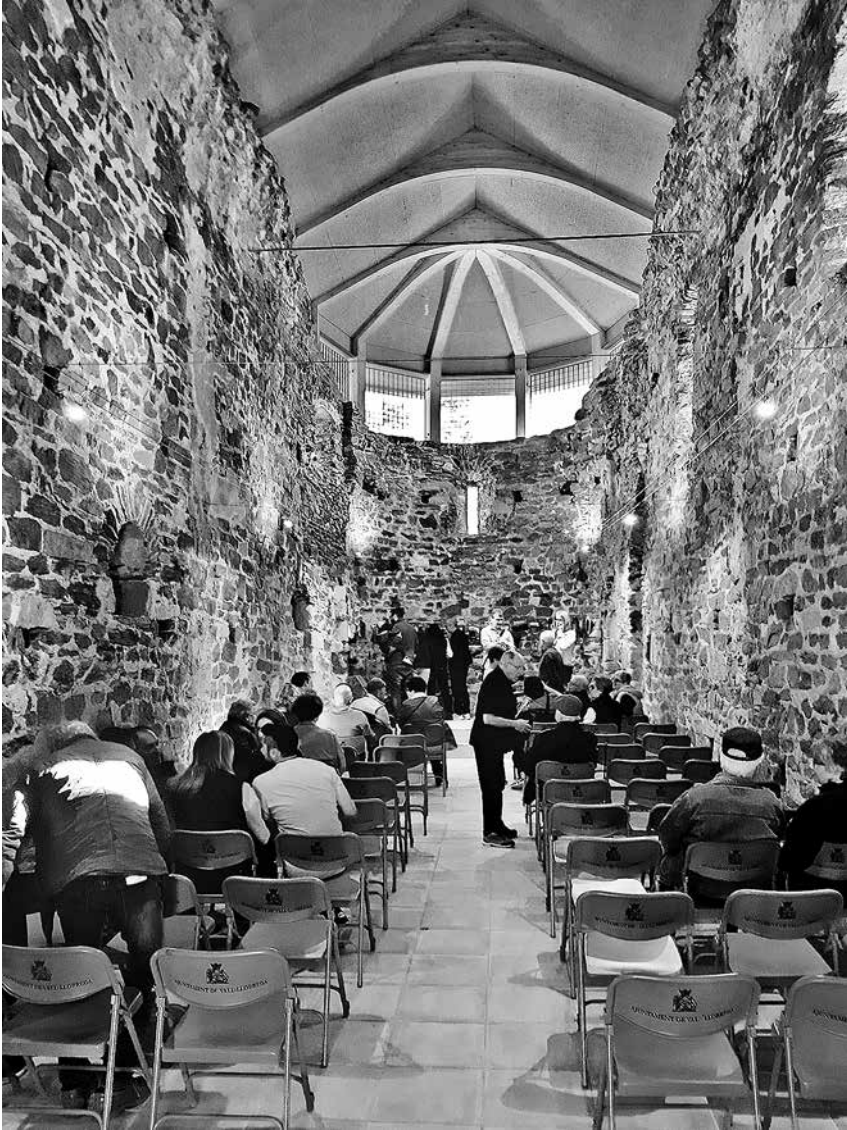
Fig. 8. Vista de l'interior de l'edifici el dia de la inauguració. Hom pot apreciar com la nova coberta es bastí damunt encavallades de fusta que intenten imitar la línia original de volta de canó i com s'ha fet a un únic nivell, sense diferenciar la nau de l'absis.
