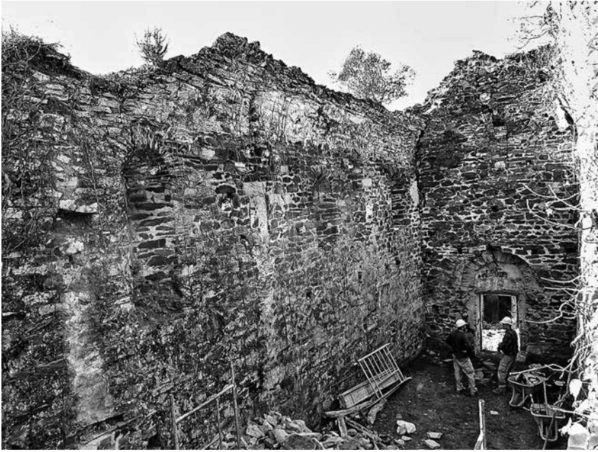
Fig. 4. Full interior del mur de migdia, on es destaquen les empremtes de dos grans arcs torals que sostenien la volta de canó. Ambdós foren totalment eliminats en una reforma que cal situar entorn del segle XV.
