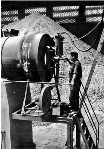
Fig. 22. Pavicsa (1967). Forn rotatiu d'assecatge de terra. Foto Serrat. Terracotta Museu Servei d'imatges.
