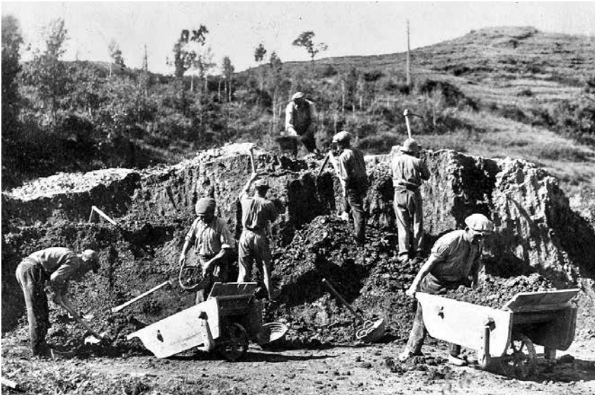
Fig. 14. Rajoleria Soler: traginant la terra de la pila cap a l'era (Ripoll, 1927) Autor: Joaquim Maynou. Arxiu Comarcal del Ripollès (ACRI).
