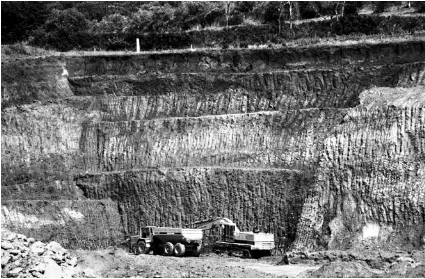
Fig. 10. Front d'explotació actiu (terreres de Vacamorta). Autor: Jordi Vicens. Terracotta Museu Servei d'imatges.
