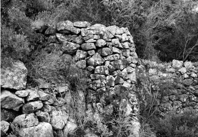
Fig. 18. Estructura cònica de pedra seca, de funció desconeguda, associada als murs superiors del vessant nord del turó d'Aiguablava. En aquesta mateixa zona hi ha altres estructures semblants, que tendeixen a situar-se a prop de les escales que travessen els murs.
