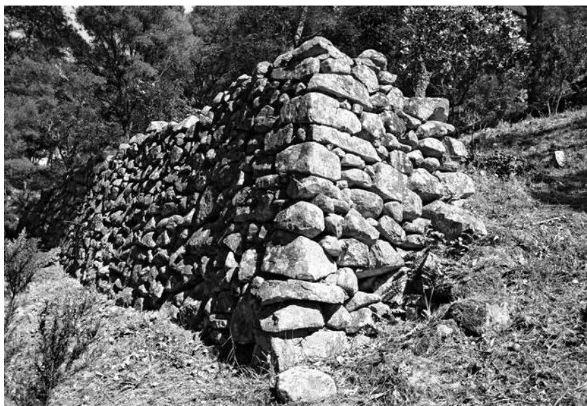
Fig. 17. Acabament lateral d'un mur de pedra seca. Sector inferior del vessant nord del turó d'Aiguablava, entre la platja i la carretera que mena al Parador.
