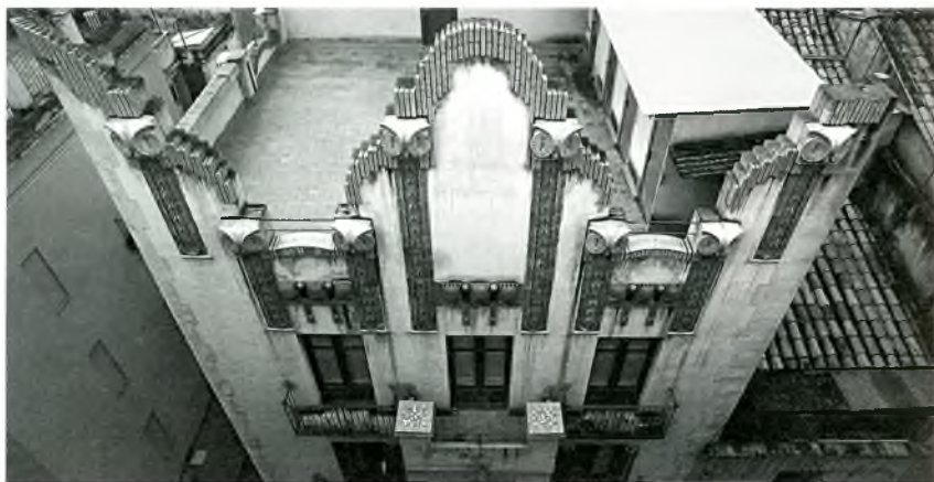
35. Vista del coronament de la façana de la casa Batlle que dona al carrer Nou. Foto: Joan del Pozo. Fons d'imatges AHCOAC. Dem. Girona.
