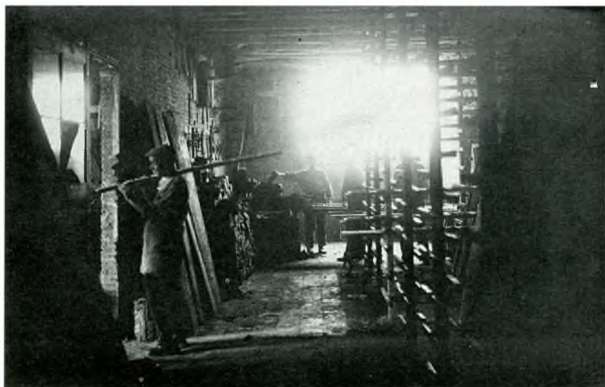
67. Fàbrica La Gabarra l’any 1916. Al fons de la nau es veu un operari introduint pans d’argila a l’interior d’una màquina galetera. Foto: autor desconegut. Fons d’imatges Terracotta Museu.
