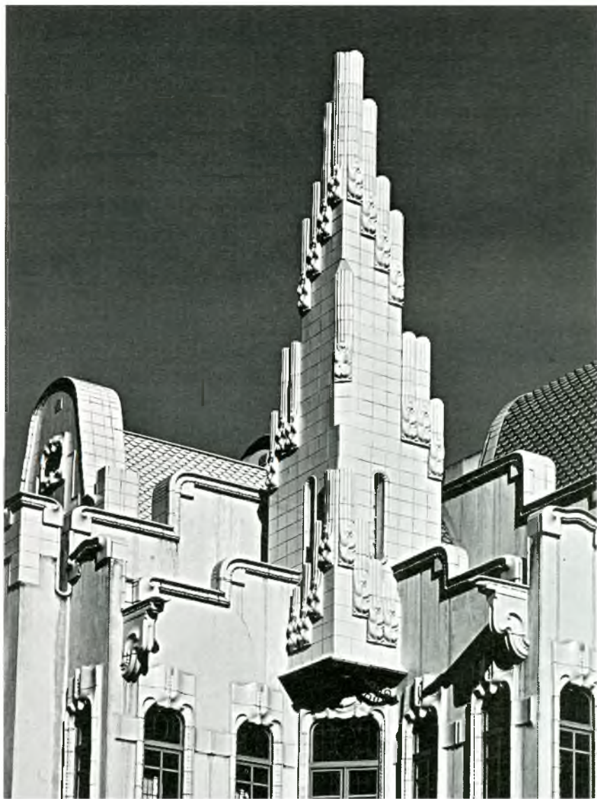
45. Detall del cos d'habitatge de la Farinera Teixidor on destaca el pinacle aguantat sobre espigues de ceràmica. Foto: Jordi Puig. Fons d'imatges Fundació Rafael Masó.
