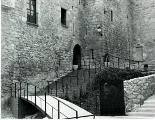
Fig. 14. Vista general del sector est (corresponent a l'accés al castell), després de les obres d'adequació del jaciment.
