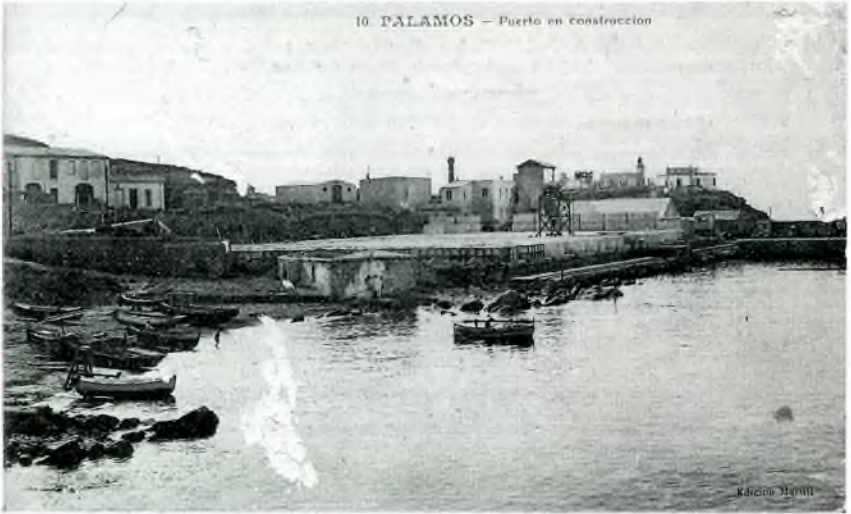
El port en construcció a principis de segle XX a la zona de la platja de la Catifa. Autor: Marull. Procedència: Fons d'imatges del Museu de la Pesca.
