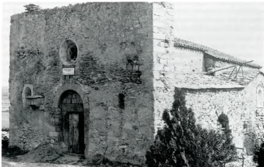
L'església romànica de Sant Joan de Bellcaire era inventariada com a obra arquitectònica que calia preservar (Foto Sans)
