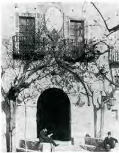
Façana principal de Sant Jeroni de la Murtra amb les cel·les que miren a mar construïdes el 1519 mercès al donatiu de l'Emperador Carles I. (Arxiu del Monestir)
