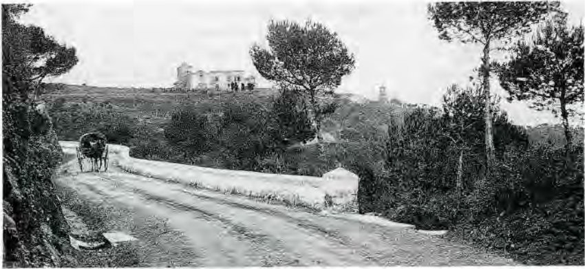
Carretera d'accés a l'ermita de Sant Sebastià (Fot. L. Roisin).
