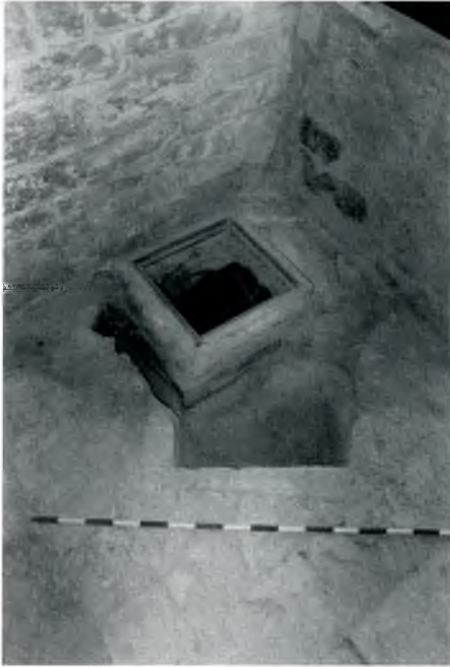
Fig. 12.- La construcció d'una arqueta de llum va comportar la destrucció parcial de la base de sustentació d'una premsa mecànica.
