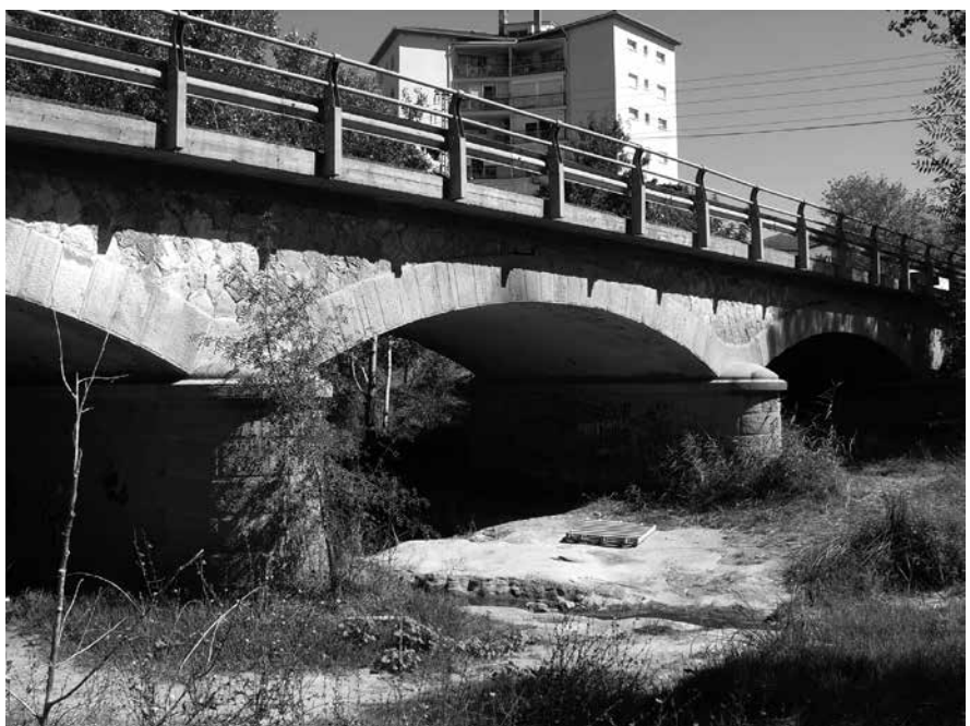
Pont del Xup, construït el 1914.
