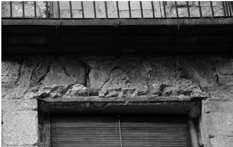
4. Moltes de les obres que s'han dut a terme en els edificis poden quedar fossilitzades en les seves façanes. A la foto s'observen tres fases constructives en una façana de la Plaça del Mercat.
