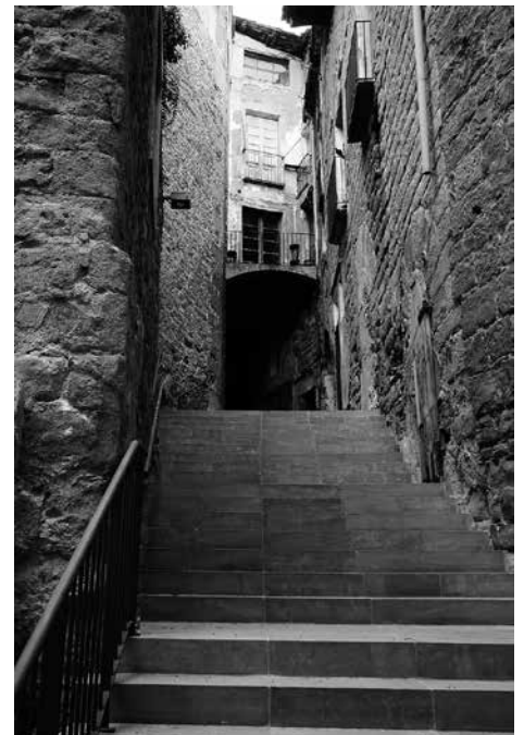
11. El carrer de l'Església després de les obres de pavimentació del carrer.
