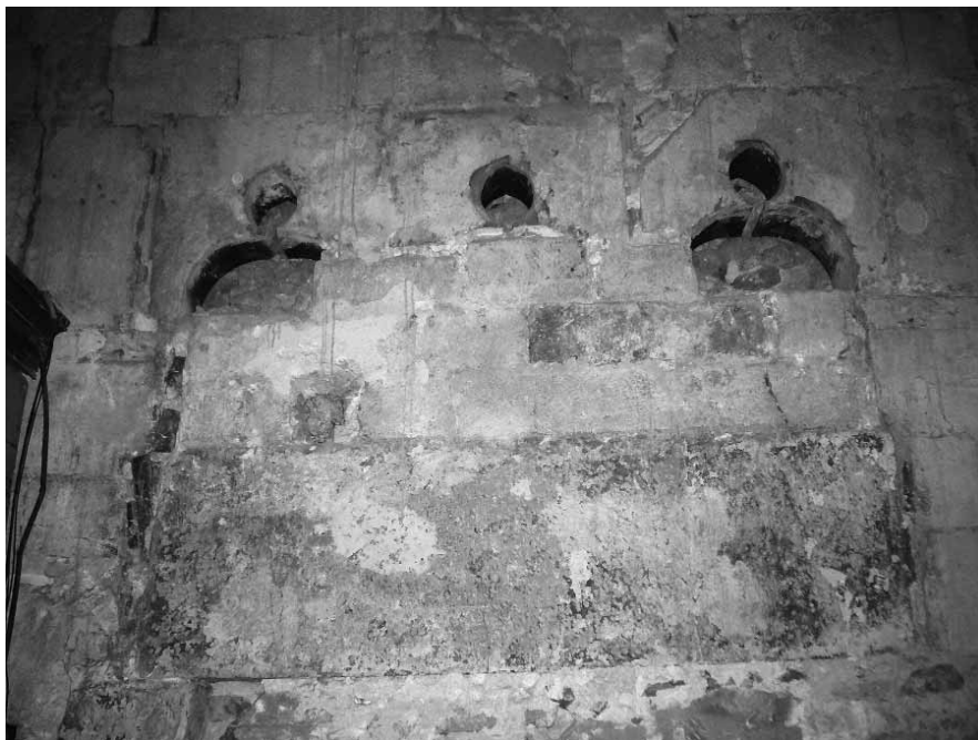
Finestra coronella de tres àmbits amb arcs trilobats tapiada que donava al pati gòtic de l'edifici.
