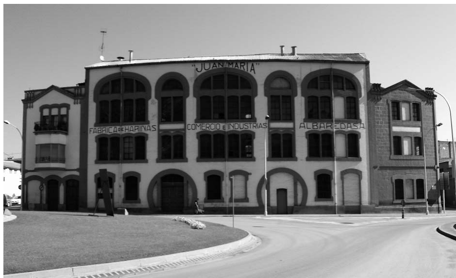
Vista frontal de la farinera Albareda, obra d'Alexandre Soler i March feta en diverses fases, encara en funcionament (foto: Lucía Juárez / Lluís Virós)
