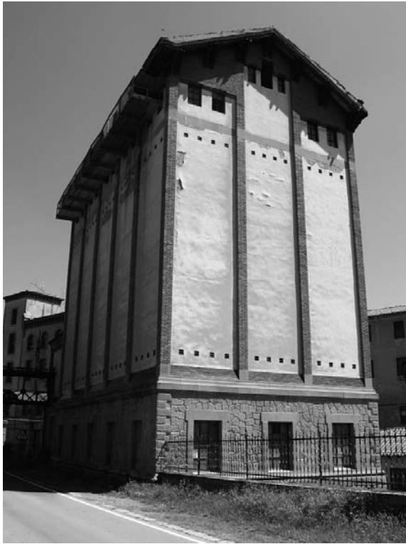
Edifici de les sitges de la farinera la Favorita, obra d'Alexandre Soler i March (foto: Lucía Juárez / Lluís Virós)
