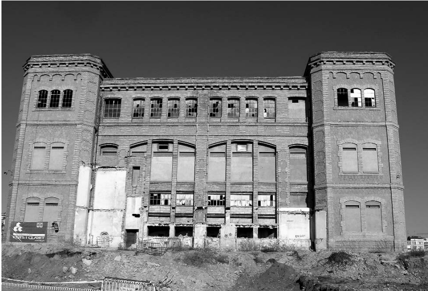
Façana sud de la fàbrica Nova de Textiles Bertrand y Serra SA, just després de l'enderrocament de la resta d'edificis del recinte industrial. (foto: Lluís Virós)
