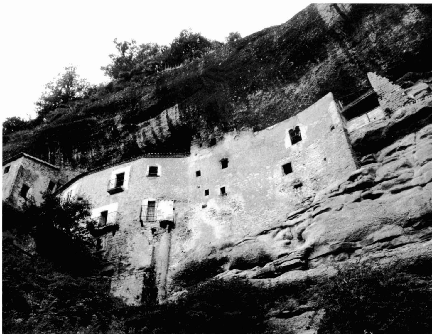
El Puig de la Balma (Mura). Casa obrada sota una gran balma natural, que conserva encara diversos elements arquitectònics medievals.
