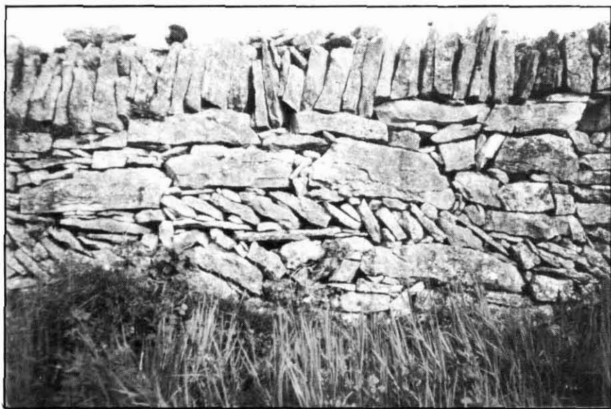
Detall d'un marge fet de pedra seca, al terme de Calders, on es veu l'acurat treball del constructor. (Foto: Josep M. Soler i Bonet).
