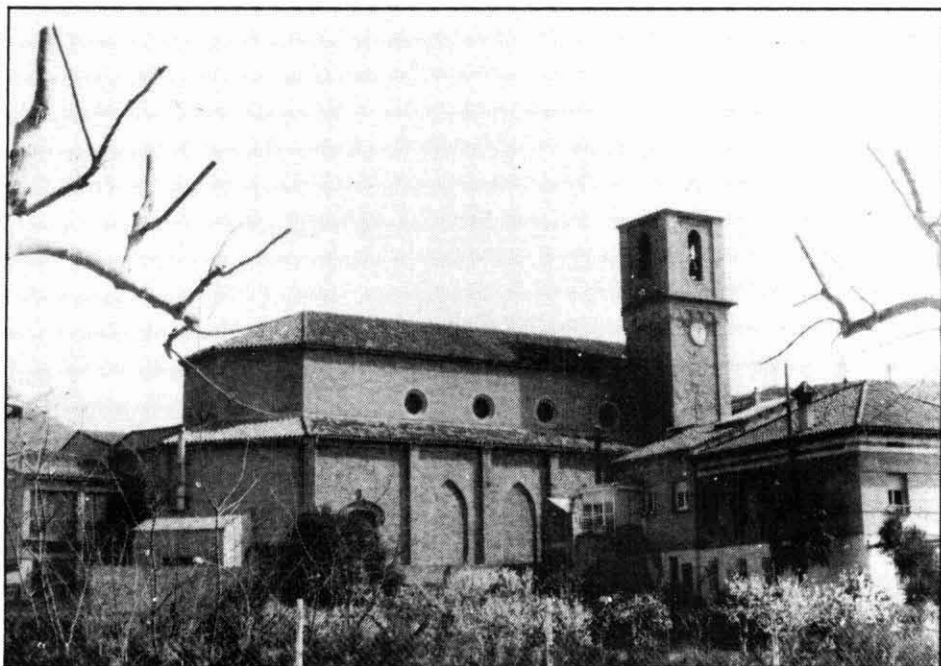
Façana lateral actual. (Foto: Jordi Suades).
