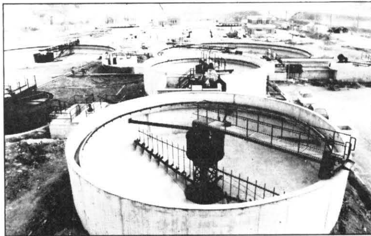
Vista parcial de la depuradora. En primer terme, espes-sidors de fangs.
