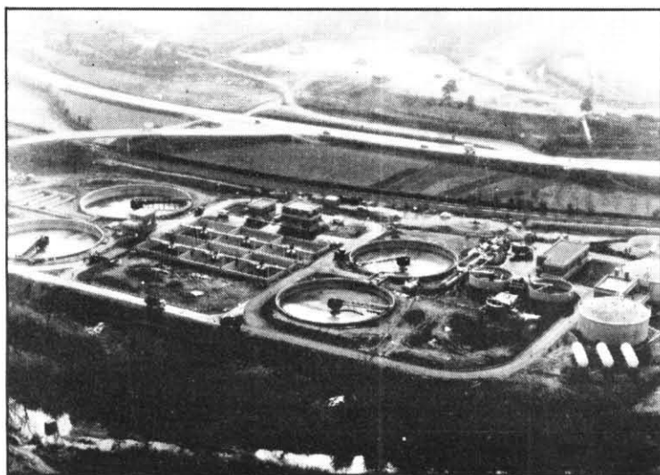
Planta depuradora d'aigües residuals de Manresa i Sant Joan. Vista general.
