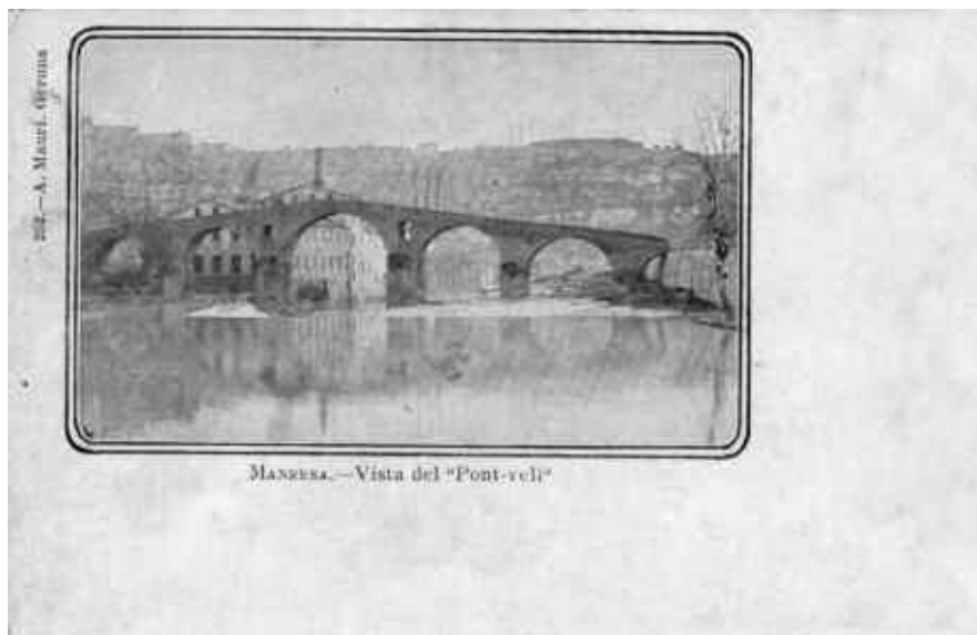
7. Postal número 252 de la sèrie de Catalunya que va editar el fotògraf gironí Amadeu Mauri i Aulet l'any 1902 d'una vista del pont Vell on es pot apreciar clarament com l'arcada de la dreta es va escapar per construir la carretera de Manresa a Martorell. Originàriament el pont tenia set arcades, tres a banda i banda de l'arcada central. El disseny modernista, en aquest cas, es limita a les dues ratlles que emmarquen la vista amb les arestes arrodonides.
